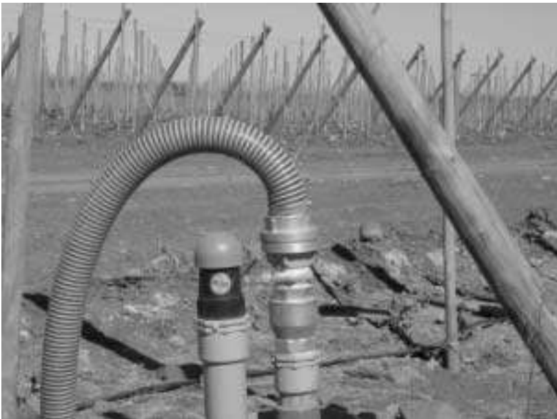
Válvula de aire y cargado de pulverizadora.
