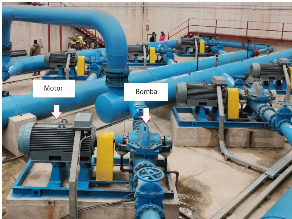
Figura 4.2. Componentes de una bomba de riego.
